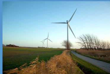
1985: Selskabet Ærø Vindenergi oprettes, 11 møller á 55 KW rejses 2001: Gamle møller tages ned, der rejses tre nye 2 MW møller ved Rise Mark 2011: Tre 2 MW møller rejses ved Vejsnæs. Ærø leverer nu mere el end der forbruges
